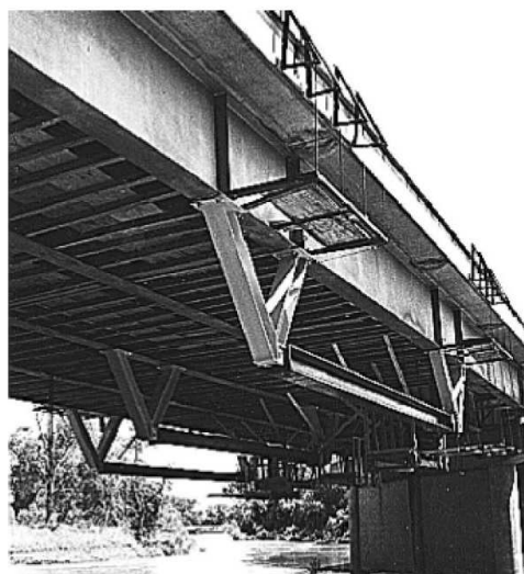
Figura 3.7: Ponte Walnut Creek - Figura extraída de Soong and Spencer Jr. (2002).
