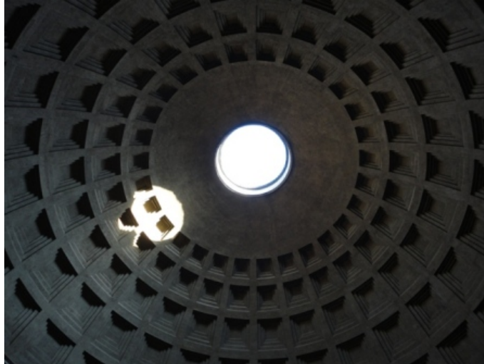
Figura 1.1: Cúpula do Panteão Romano em cimento pozolânico e agregado leve, com alvéolos que reduzem o peso da estrutura
